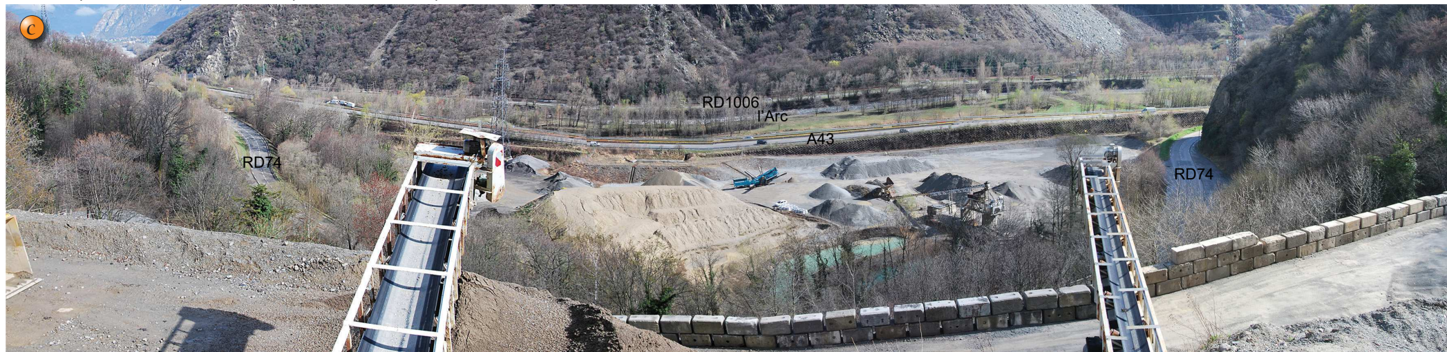
Vue sur la plateforme de produits finis, depuis les installations primaires
